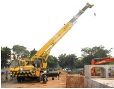
Gambar 1.11 Mobile Crane Sumber: Dokumen Pribadi
