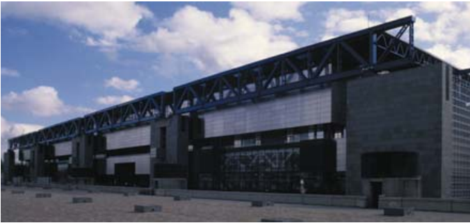
▲ 4.23 Cité des Sciences et de l'Industrie, Paris, France, Adrien Fainsilber, 1986. Scaled-up columns relate to building scale and truss dimensions.
